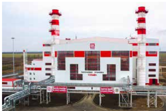
Котельная Запикетная г. Кисловодск
